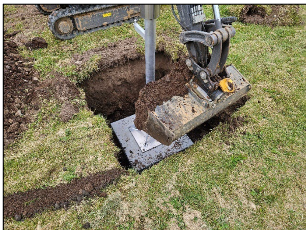
Figur 7 Udgravning til reflektor.
